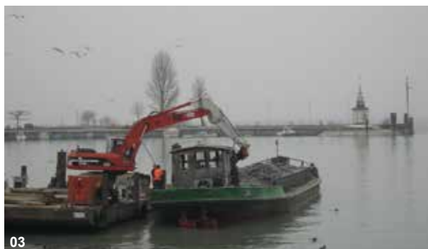
01 Anlegestelle mit Blick zum Museum im alten Zollhaus 02 Einschwimmen der neuen Steganlage 03 Nassbaggerung mit Verlad auf Kiesschiff
